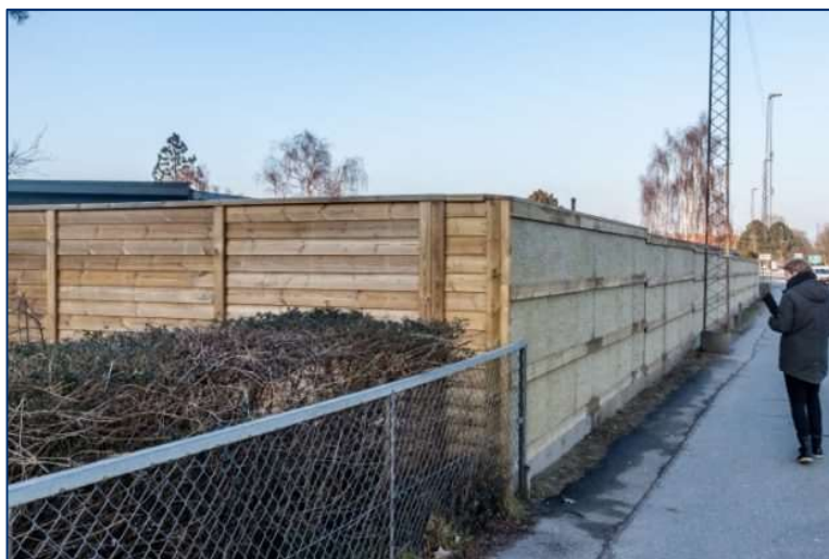
Figur 36. Her har grundejeren bygget sit eget støjhegn og brugt mineraluld på siden mod vejen. Hegnet har formentlig en god støjdæmpende virkning fordi det er tæt, har en god højde og går op i skel vinkelret på vejen. Mineralulden har ingen betydning for hegnets støjdæmpende virkning hos grundejeren.
