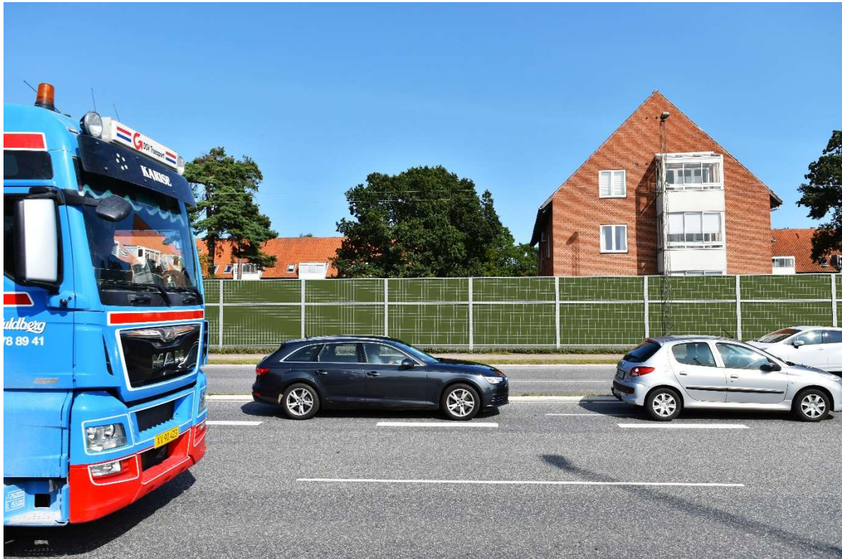
Figur 28: Eksempel på støjskærm ved et etageboligområde. Støjskærmen dæmper støjen på de udendørs opholdsarealer bag skærmen og for boligerne i stueetagen, men ikke for boligerne på 1. og 2. sal.
