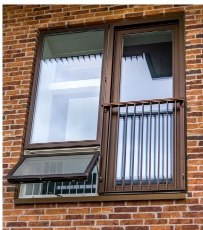
Figur 32. Støjdæmpende multifunktionsvindue (billederne til venstre og i midten). Støjen dæmpes på vejen gennem åbningen for neden (udendørs) til åbningen for oven (indendørs). Til højre er vist en lydskodde, som er monteret foran et eksisterende vindue. Den dæmper støjen, men giver også adgang for frisk luft. Den kan desuden mørkelægge et rum, hvis det ønskes.
