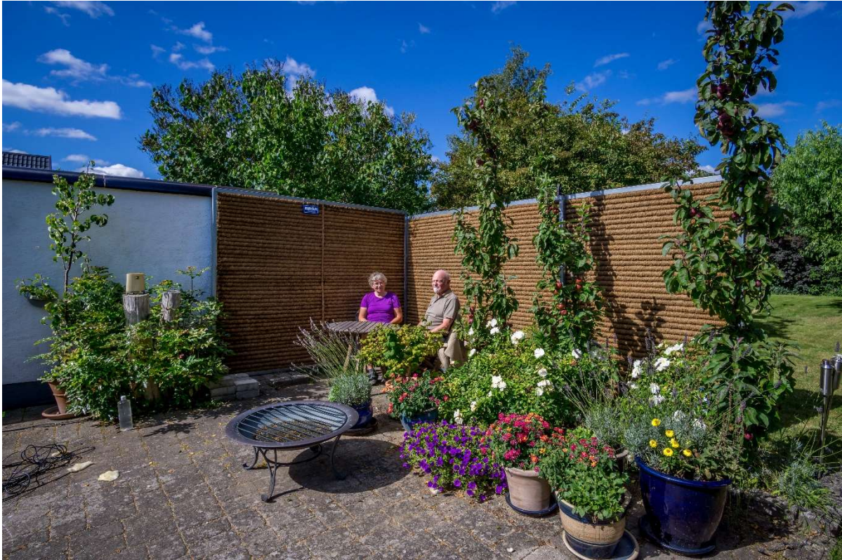
Figur 35. Et støjhegn kan skabe en støjafskærmet krog eller terrasse. Den støjdæmpende virkning kan opleves i et mindre område lige op af hegnet (fra en forsøgsopstilling i en have i Glostrup).
