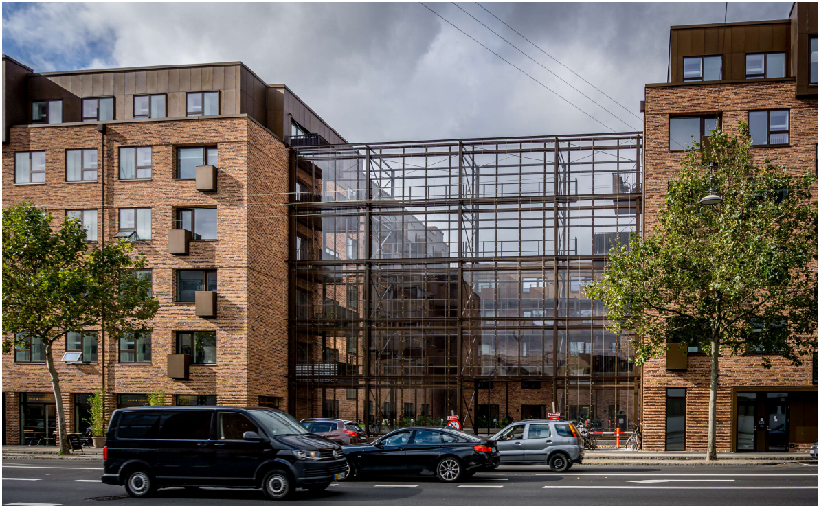
Figur 31. I denne nye bebyggelse, har man anvendt en støjskærm i åbningen mellem bygningerne for at opnå et lavt støjniveau i bebyggelsens gårdmiljø. I facaden mod vejen er der anvendt særligt støjdæmpende vinduesløsninger (Gl. Køge Landevej, København).
