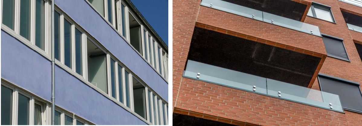
Figur 33. I ejendommen til venstre blev altanerne forsynet med en forsatsrude, der kan skydes til siden. Når ruden er lukket, fungerer den sammen med altanrummet som en meget effektiv støj dæmpning. Til højre er vist åbne altaner med en glasafskærmning, der begrænser støjen. Der er desuden et lydabsorberende akustikloft, som dæmper støjen i altanrummet.
