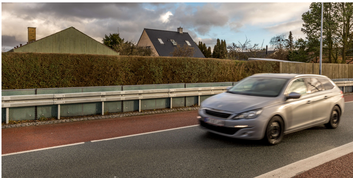
Figur 27. Autoværn, der er udformet som en lav støjskærm. Selvom skærmen er lav, kan der være en støjdempende virkning, fordi den står meget tæt på støjilden (Vejlegårdsvej, Vallensbæk Kommune).
