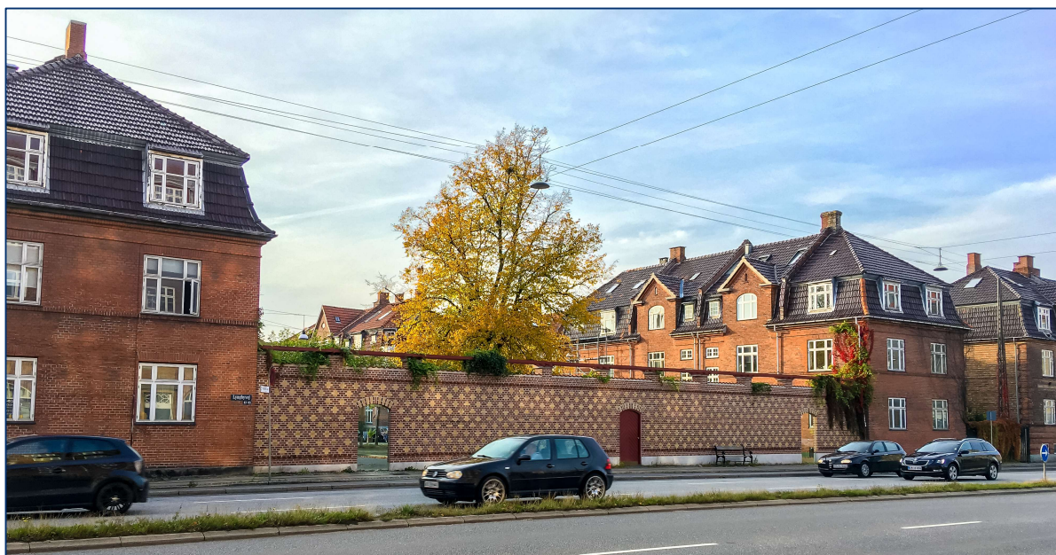
Figur 38. Her har en grundejerforening bygget en støjskærm i åbningen mellem to husrækker. Resultatet er et støjbeskyttet område bag skærmen (Lyngbyvej, København)
