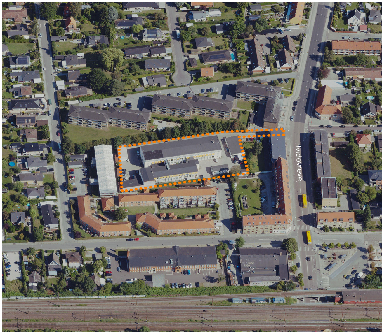
Luftfoto af Hvidovrevej 80, kilde Styrelsen for Dataforsyning og Effektivisering.
