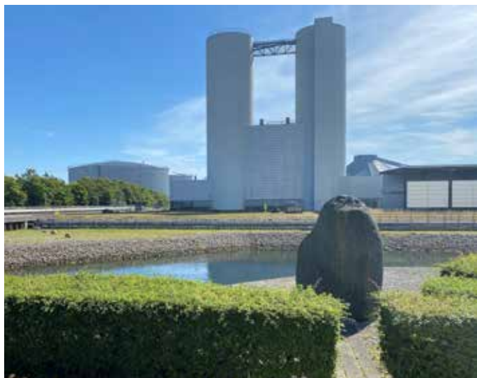
Åbent areal centralt i området omkring kølevandskanalen.
