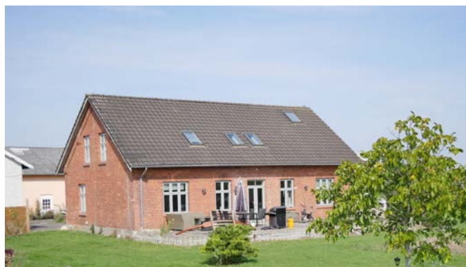
Det bevaringsværdige hovedhus på Brostykkevej 190.
