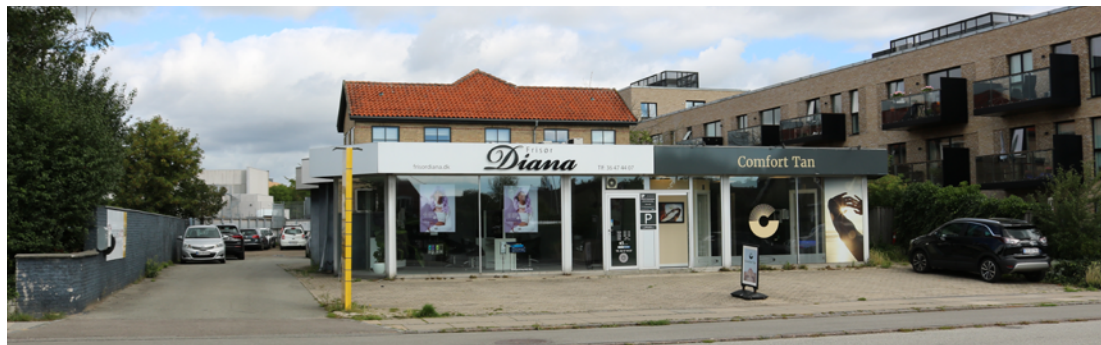
Landlystvej 44 - eksisterende forhold
