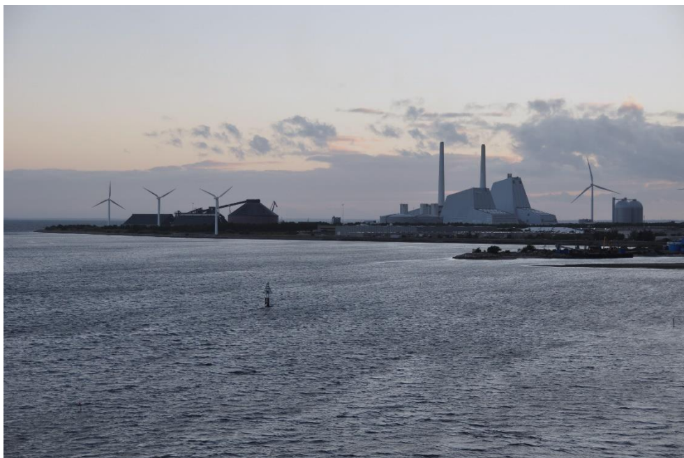
Figur 6-12 Punkt 2: Kalvebodbroen, aften – eksisterende forhold.
