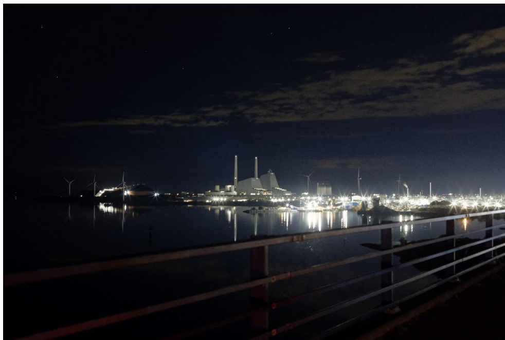
Figur 6-14 Punkt 2: Kalvebodbroen, nat – eksisterende forhold.
