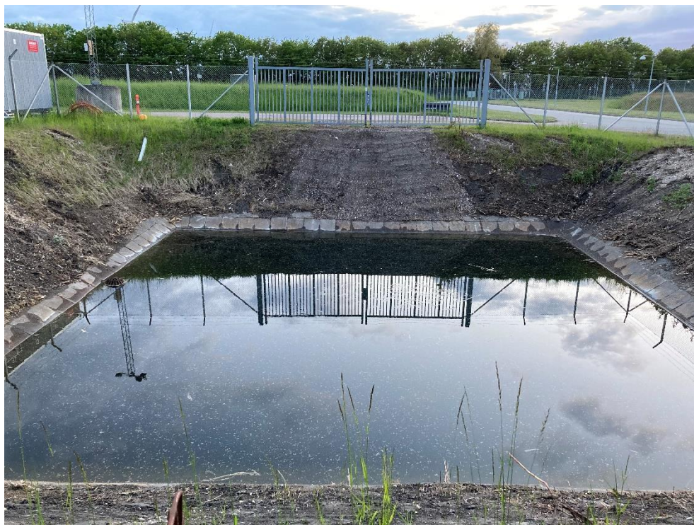
Figur 5-3 Det lille regnvandsbassin i den vestlige del af Avedøreværkets areal som den fremstod ved besigtigelsen d. 21. maj, efter den blev oprenset midt i maj.
